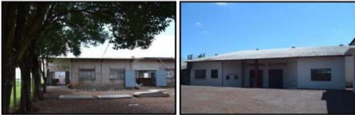
Figura 124 – Vistas das estruturas da Linha Dr. Ernesto (esq.) e Linha Flórida (dir.).
