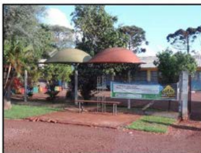
Figura 117 – Vista do equipamento de educação localizado em Boa Vista.
