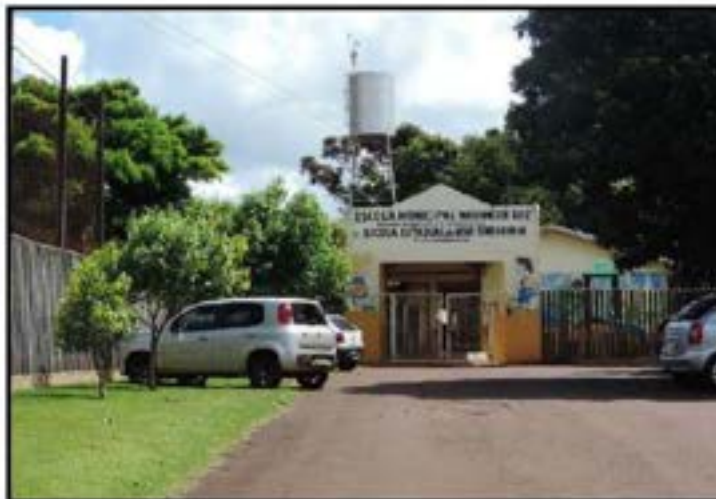
Figura 115 – Vista do equipamento de educação de Novo Sobradinho.
