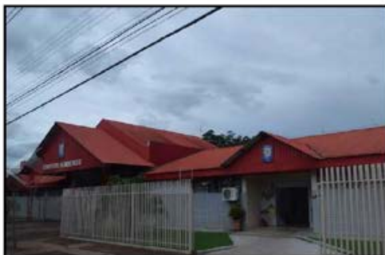
Figura 130 – Vista do Quartel Central do Corpo de Bombeiros.
