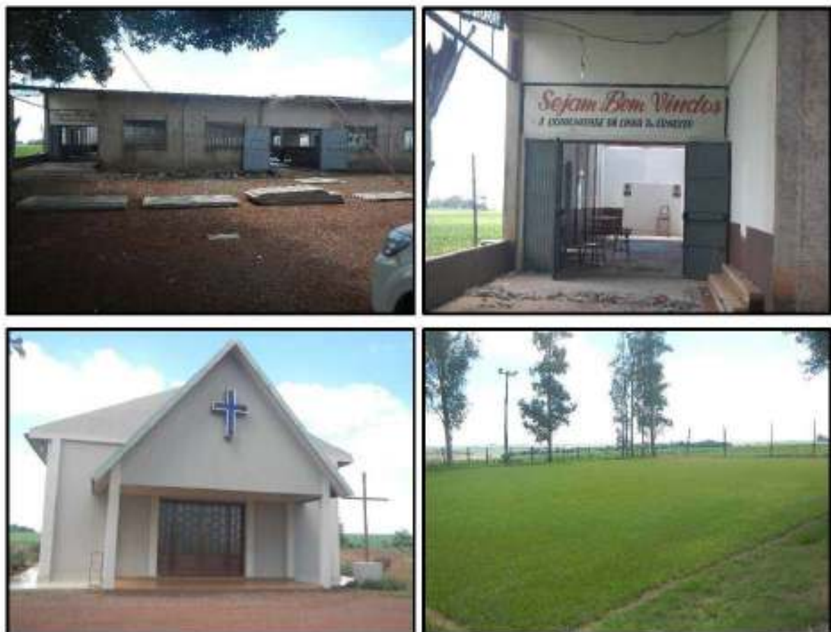
Figura 275 – Vistas do salão, igreja e campo de futebol da localidade Linha Doutor Ernesto – entorno próximo a ADA.
