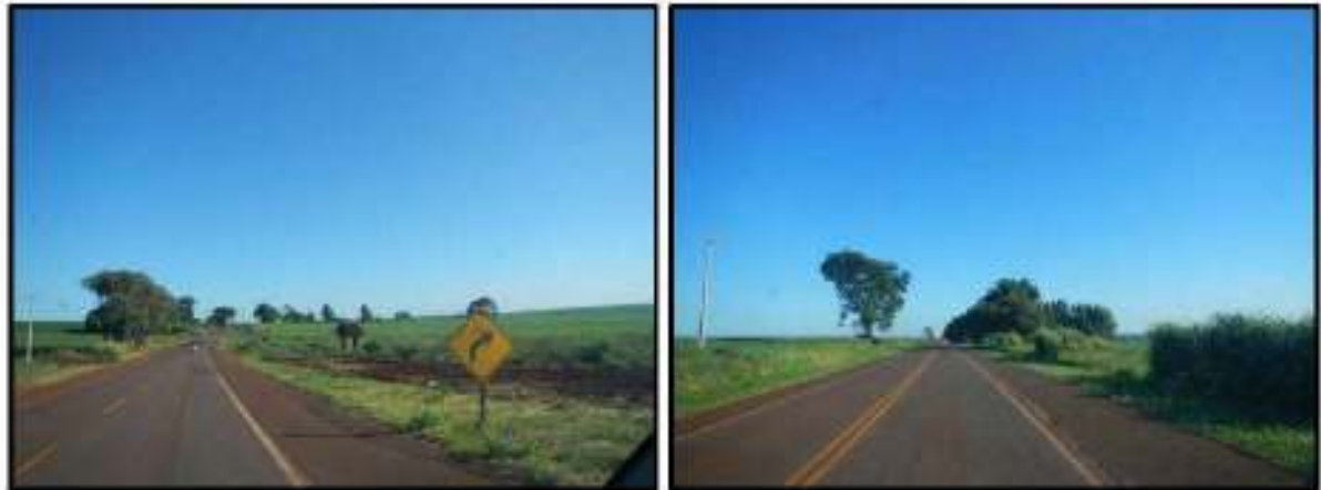
Figura 346 – Vistas da Rodovia PR-182.
