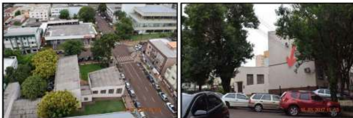
Figura 350 – Bem tombado estadual Fórum Wilson Balão.
