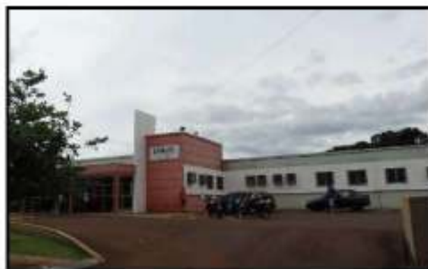
Figura 248 – Vista da Unidade de Pronto Atendimento 24h.
