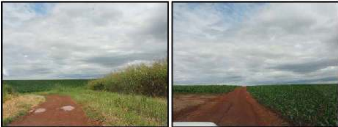
Figura 348 – Vistas de estradas rurais não pavimentadas, de acesso ao empreendimento.
