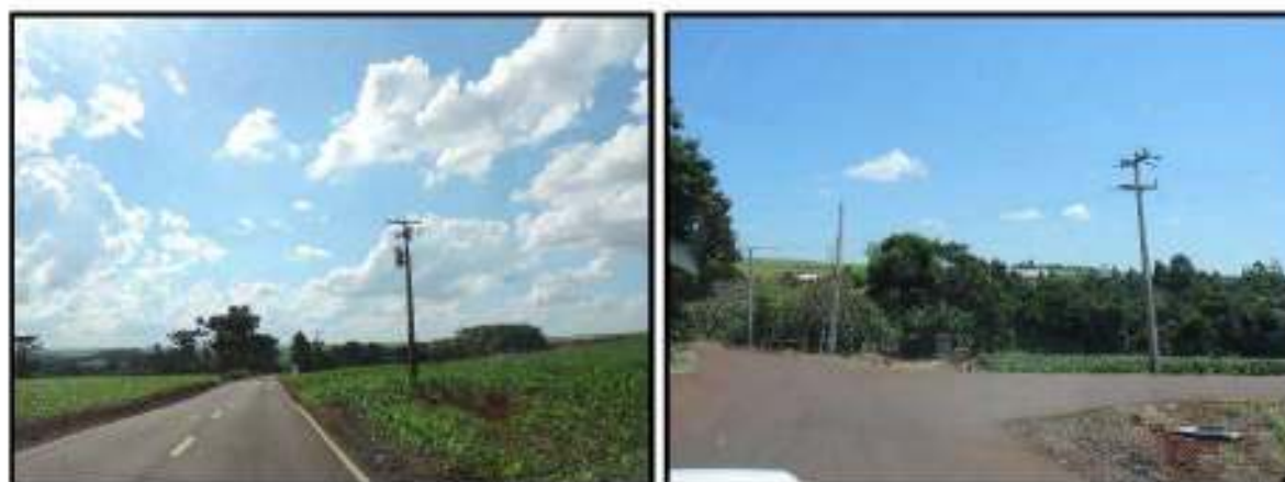
Figura 289 – Infraestrutura de energia elétrica identificada.
