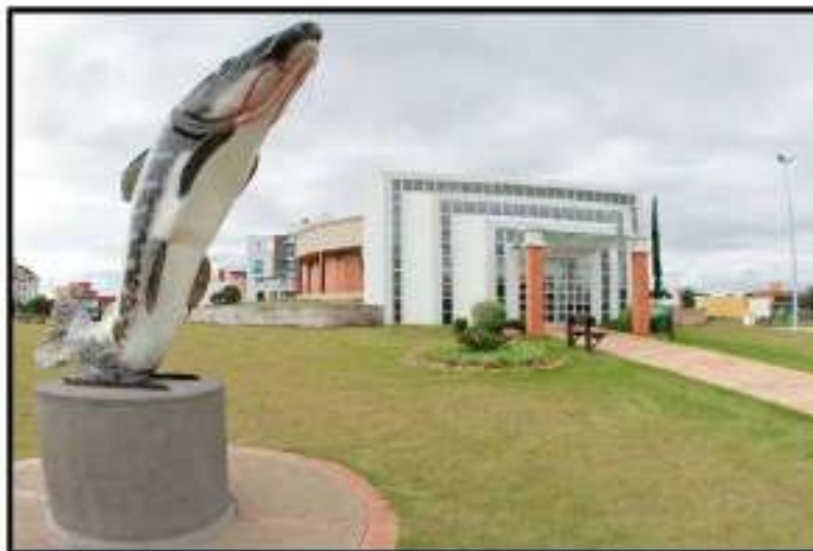
Figura 258 – Vista do Aquário Municipal.
