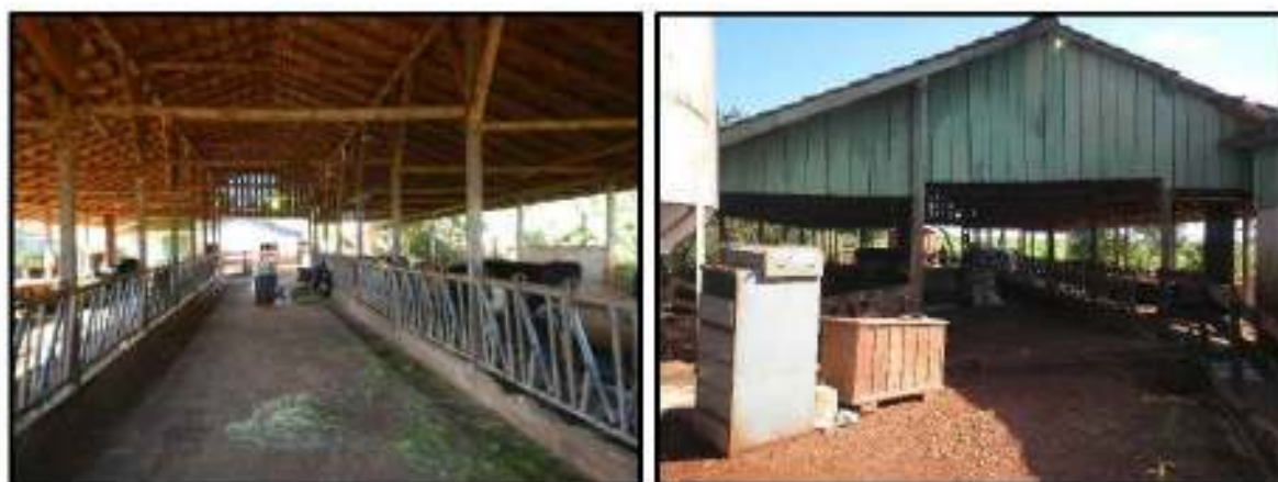
Figura 293 – Vista de barracão para criação de bovinos identificado na ADA.
